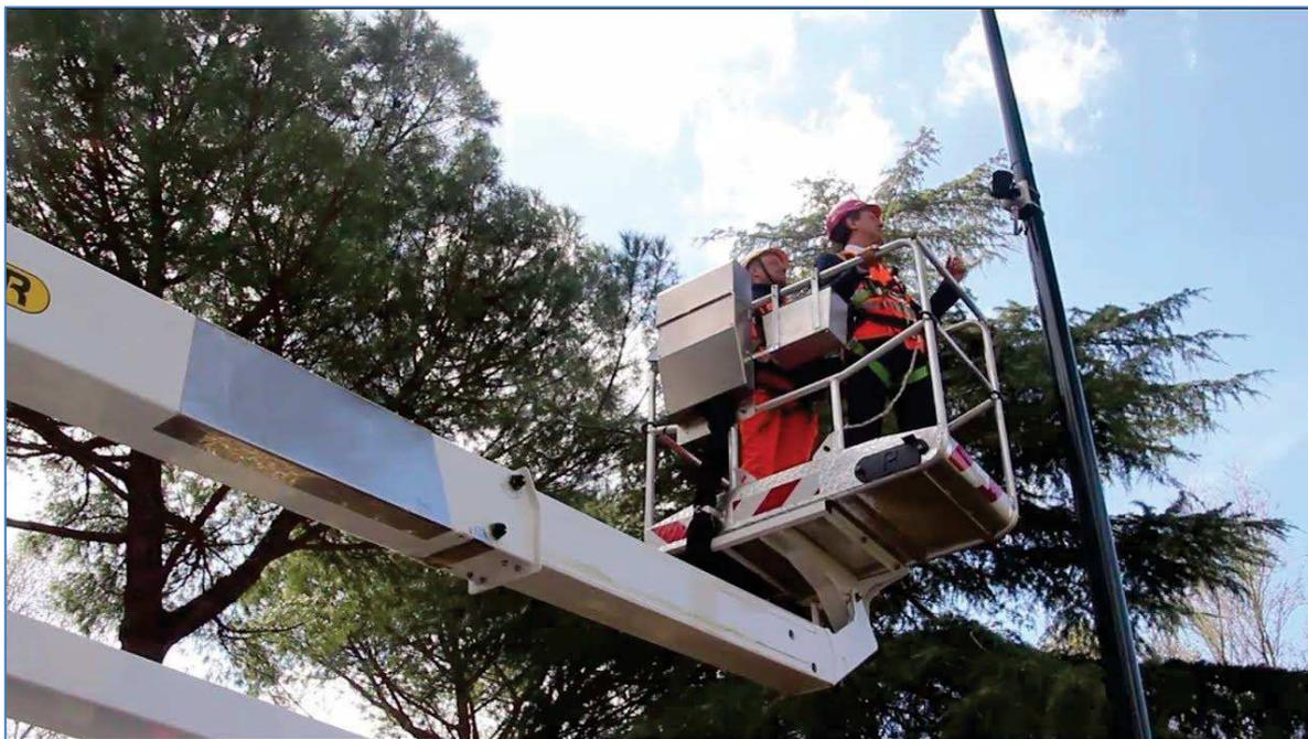
Pertanto dovrà essere segnalata l'area di intervento facendo in modo che non vi sia transito di persone nel raggio d'azione dei mezzi d'opera. Dovranno essere preventivamente individuati i posizionamenti di mezzi di supporto e P.L.E., verificando inoltre la stabilità del piano di posa in corrispondenza di tali punti, prima di procedere con la singola fase lavorativa.
